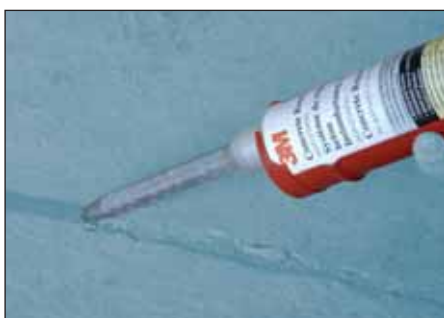
Reparation af revner og huller i betongulve 3M Scotch-Weld DP600SL
